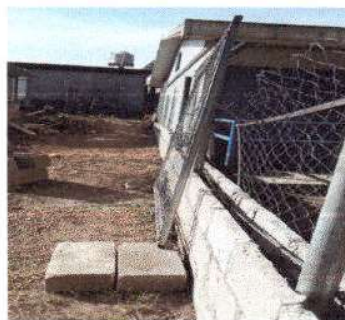
Foto 2: Reparación de Tubo HG y malla galvanizada en muro perimetral
