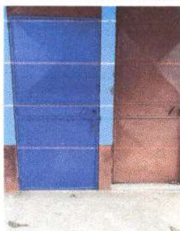
Foto 3: Mantenimiento a puertas de metal en aula 1, 2, 3, 4
