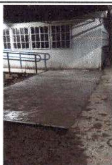
Foto 5: Sustitución de piso de tierra con torta de concreto
