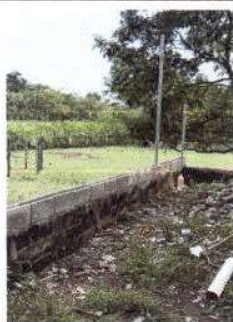
Foto 1: Reparación de block con tubo HG y malla galvanizada, soleras intermedias y columnas en muro perimetral
